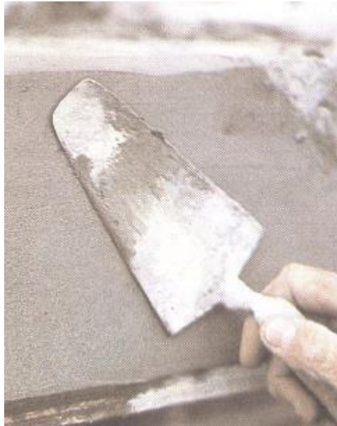
Figura 8 - Acabamento da superfície reparada.
