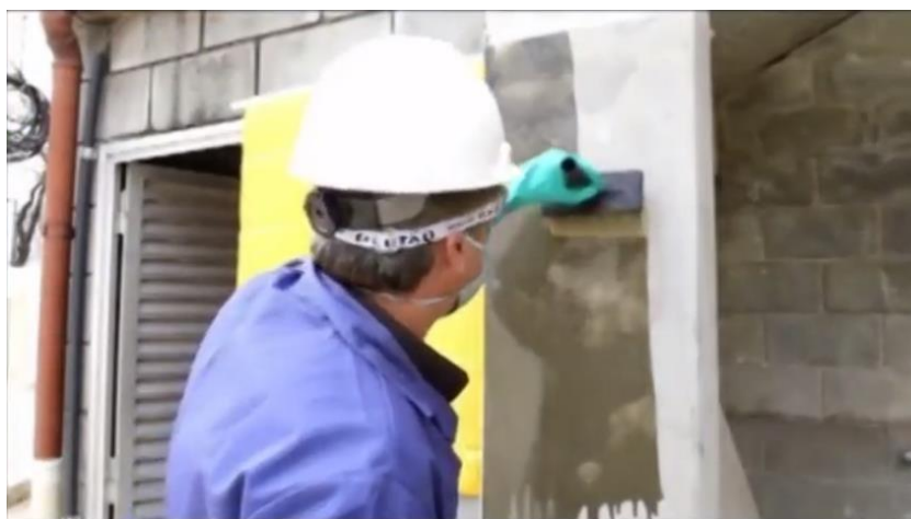
Figura 9 - Aplicação de hidrofugante com trincha.
