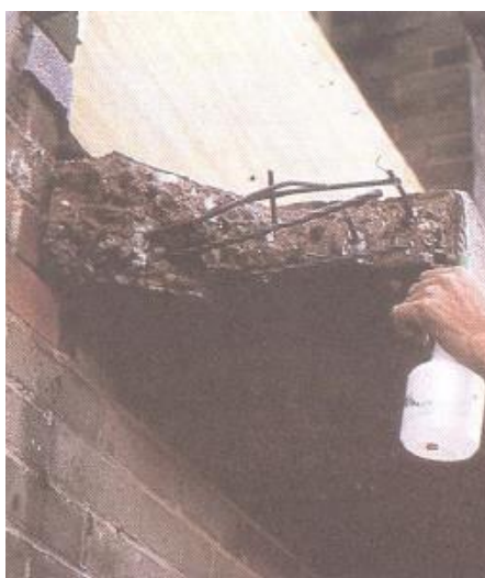
Figura 7 - Saturação da superfície.
